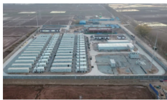
中国宁夏 板桥项目100MWh/200MWh
