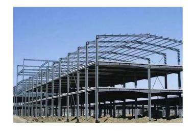
材质 Material 钢结构主要采用Q235B、Q345B低合金高强钢制造,表面经热镀锌、防火涂料或喷砂处理, 耐候性强,使用寿命达50年以上(定期维护条件下)。
