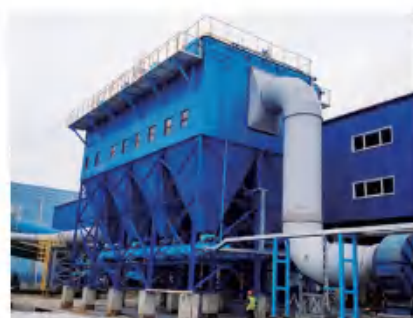
俄罗斯东方港除尘项目 Russian Vostochnyy port dust removal project
