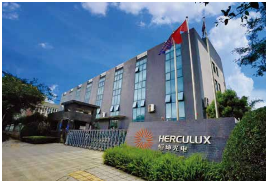
成都双流区自建超20000 m 2 恒坤光电园
