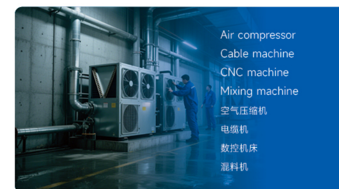
HVAC 暖通空调
