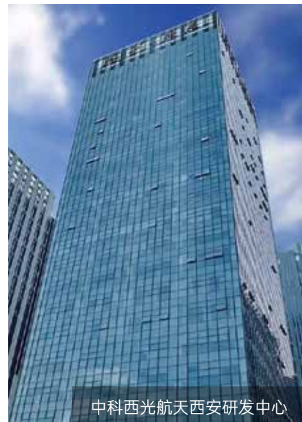
中科西光航天公司总部
