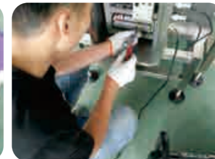
电器安装 Electrical installatio
